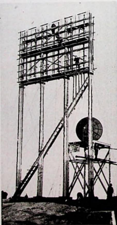
Abb. 2. Richtfunk-Antenne Hornisgrinde im Aufbau
